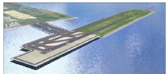
Nieuwe landingsbaan Haneda Airport Tokyo, tijdens de bouw 2009
